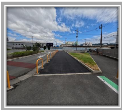
場内道路の舗装
