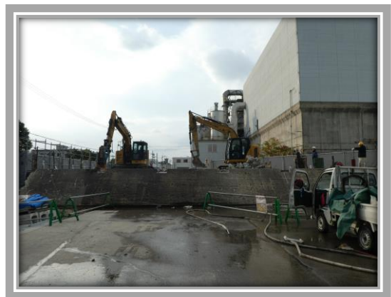
計量棟周辺の整備
