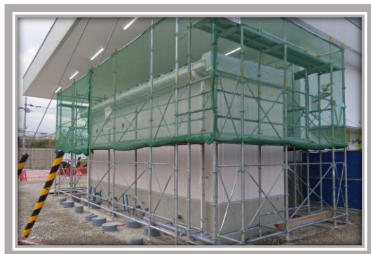
トイレ棟の建設
