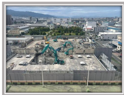
プラットホーム解体の様子
