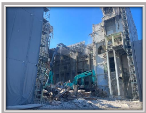
工場棟解体の様子①
