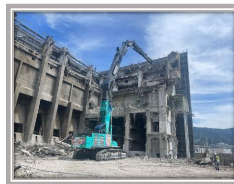
工場棟解体の様子②
