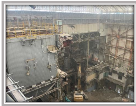
焼却炉解体の様子
