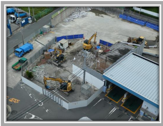
旧排水設備の解体
