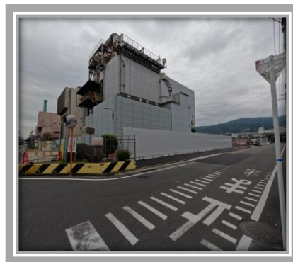
搬入口の整備
