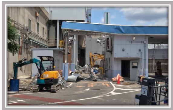
旧計量棟の解体
