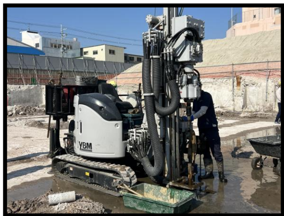
土壌汚染調査の様子①
