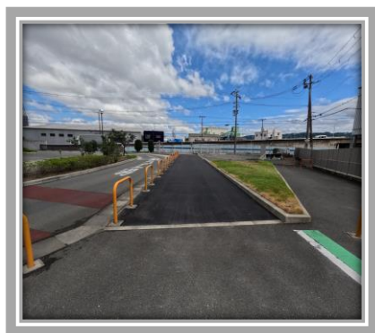
場内道路の舗装
