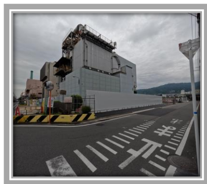
搬入口の整備
