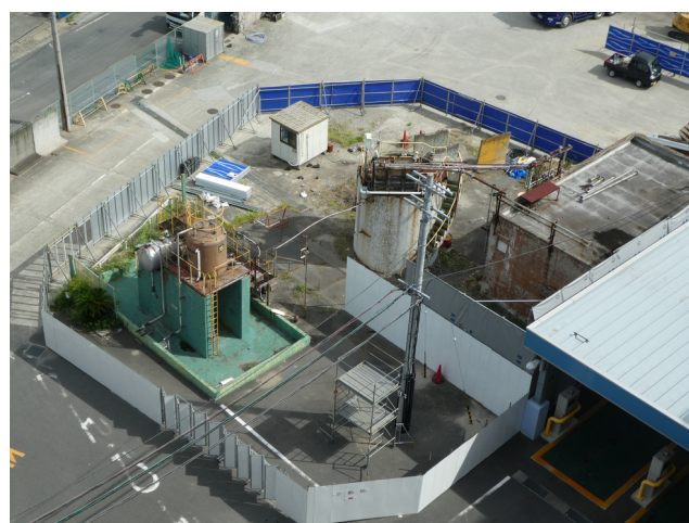
旧排水設備の解体風景です。
