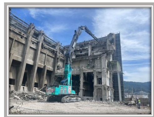
工場棟解体の様子②
