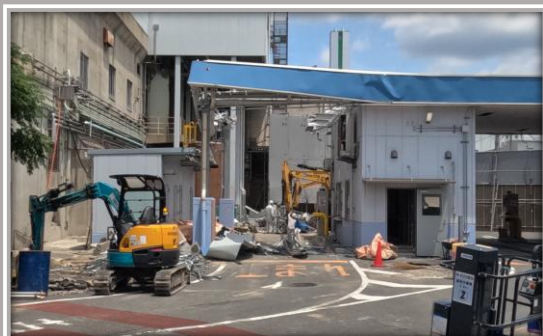
旧計量棟の解体
