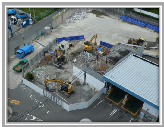
旧排水設備の解体
