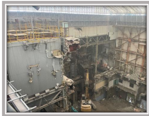
焼却炉解体の様子
