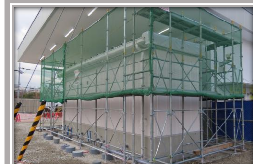
トイレ棟の建設
