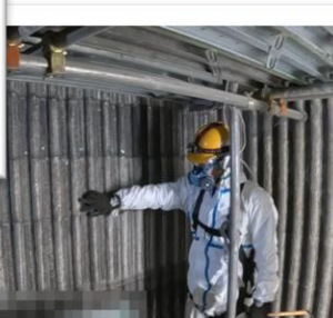
水管肉盛施工状況の確認
