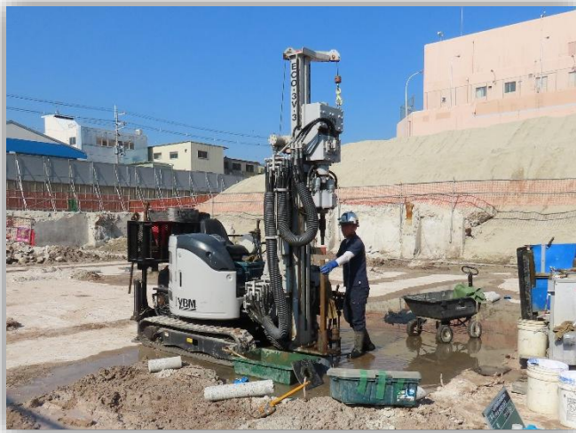
土壌調査試料採取の様子
