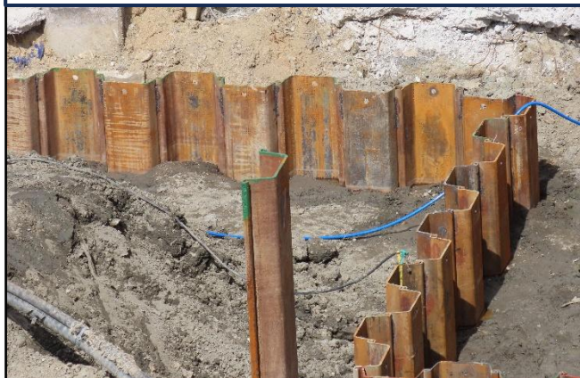
山留め打設の様子①
