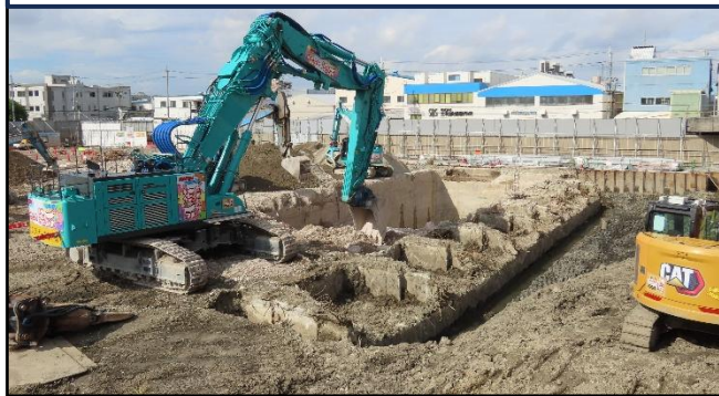
基礎解体工事の様子①
