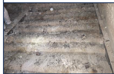
焼却炉内（清掃前）
