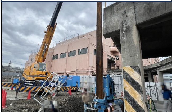
山留め打設の様子②
