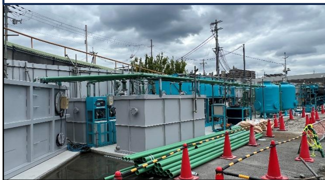
排水処理設備の設置
