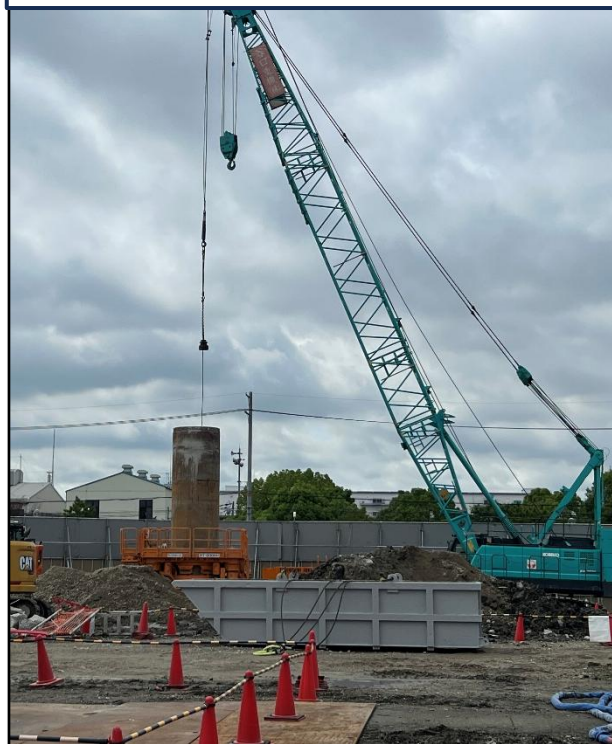
基礎解体工事の様子②
