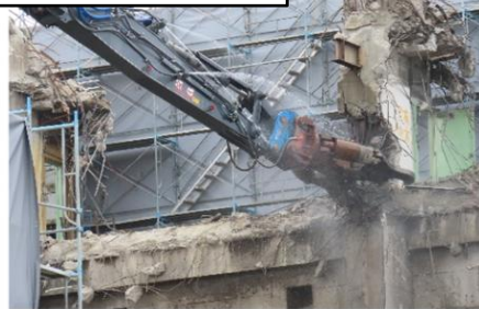
解体工事の様子②
