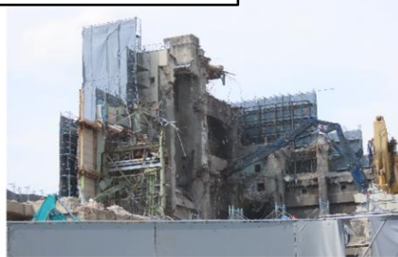
解体工事の様子①
