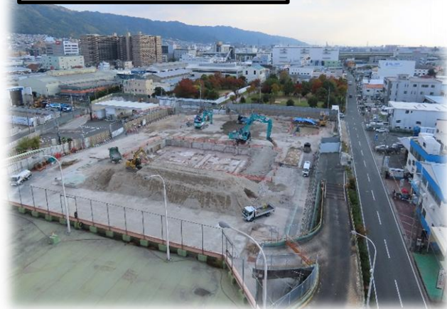
第三工場建屋 解体後
