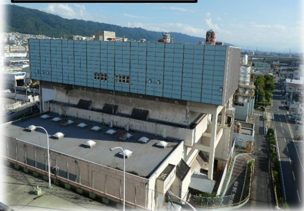
第三工場建屋 解体前
