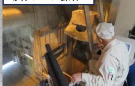
灰クレーン操作
