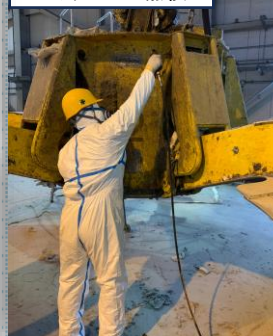
ごみクレーン点検
