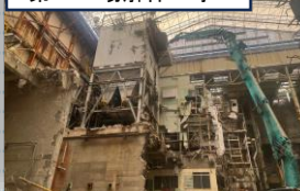
第三工場解体工事
