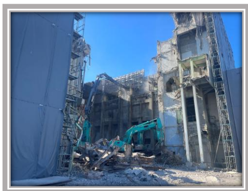
工場棟解体の様子①
