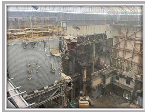
焼却炉解体の様子
