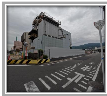
搬入口の整備
