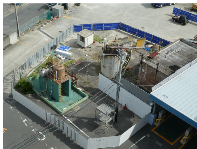
旧排水設備の解体風景です。
