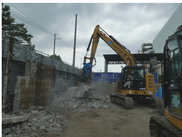
缶びん集積場南側の壁の解体風景です。
